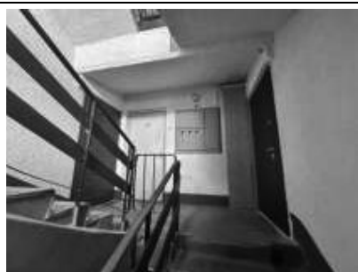
1.stāva kāpņu telpa
